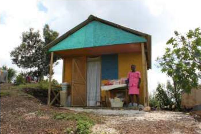
Ons laatst gebouwde prefab-huis dient ook als winkel
