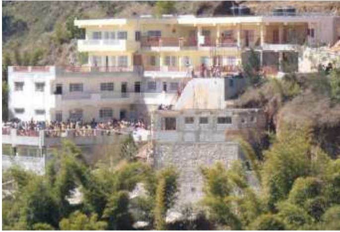
De waterbassins met er op het kantoor en keuken in aanbouw
