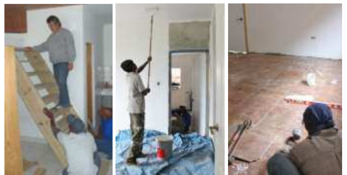
De trap, het verven en het leggen van de vloer
