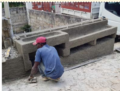
Aanleg van extra wasbakken
