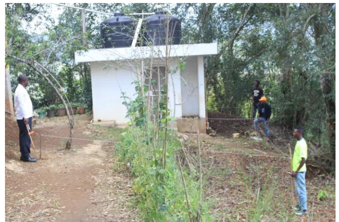
Overzicht bouwplaats broodbakkerij en vakschool
